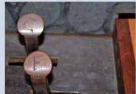
Schmiedeeiserne Registerhebel links: C (Coppel), F (Flöte)
